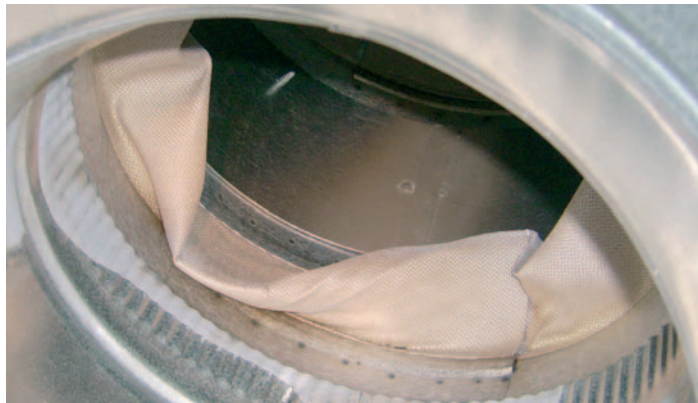
Die Verwendung von Dehnungskompensatoren erleichtert die Erfüllung der ÖNORM H 6031
